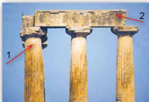
Ордер: 1 — вертикальная опора (колонна), 2 — горизонтальное перекрытие (балка)
